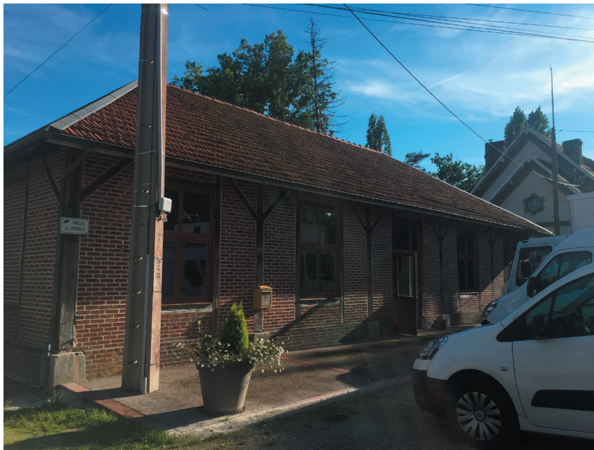
Façade côté rue des Charmes de l'Ormes
